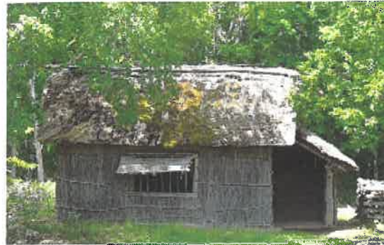
開拓者が移住当初立てた「開拓小屋」草葺きで建てられた小屋が多かった。写真は「北海道開拓の村」に再現された小屋(札幌市)
