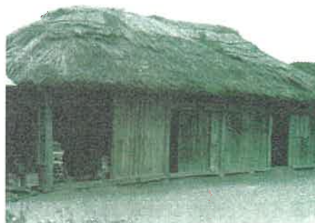
写真：杵臼の開拓者住宅（明治4年）
